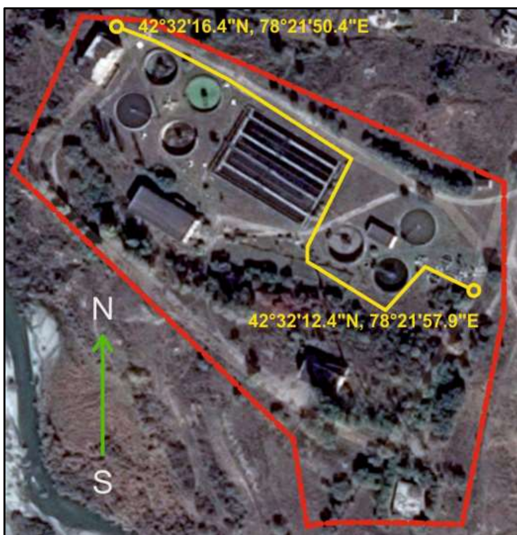
Рисунок 5. Очистные сооружения (Участок 4)
