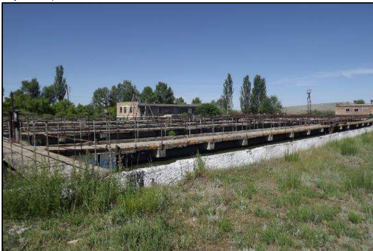
Рисунок 20. Аэротенки
