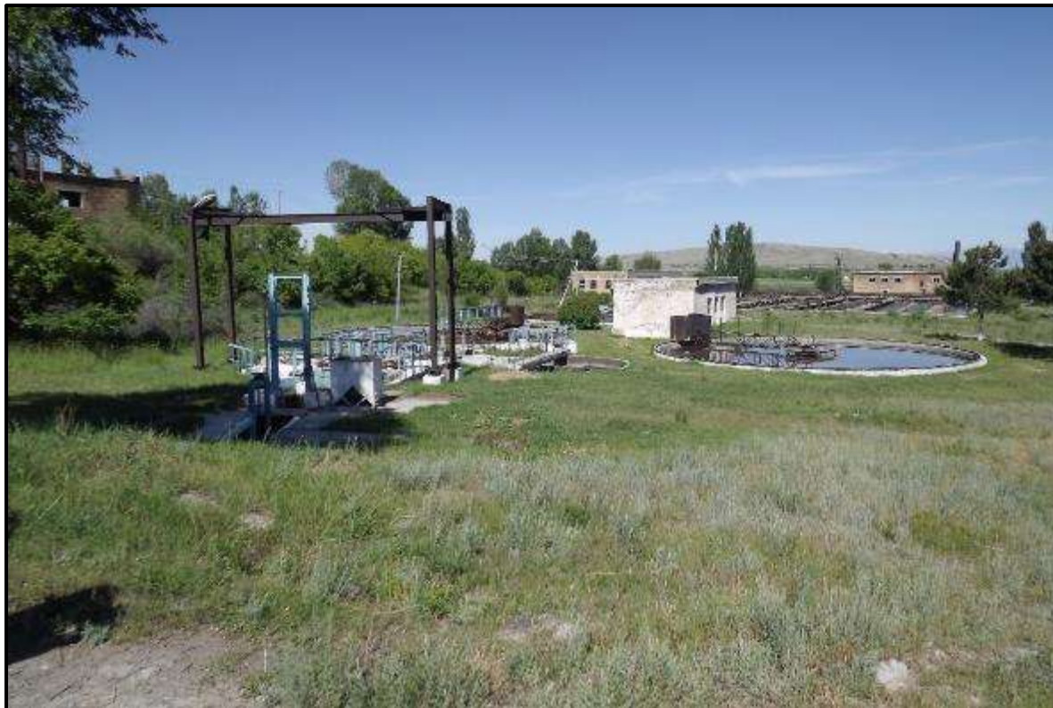
Рисунок 19. Приемный коллектор и аэротенки
