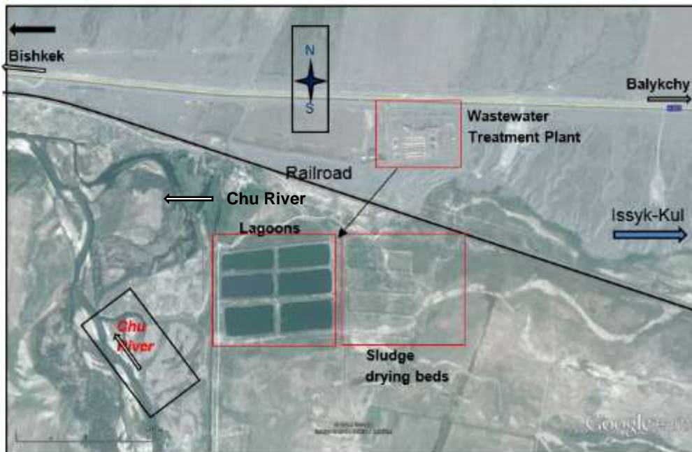
Рисунок 4 – Существующее Балыкчинское канализационное очистное сооружение и пруды
