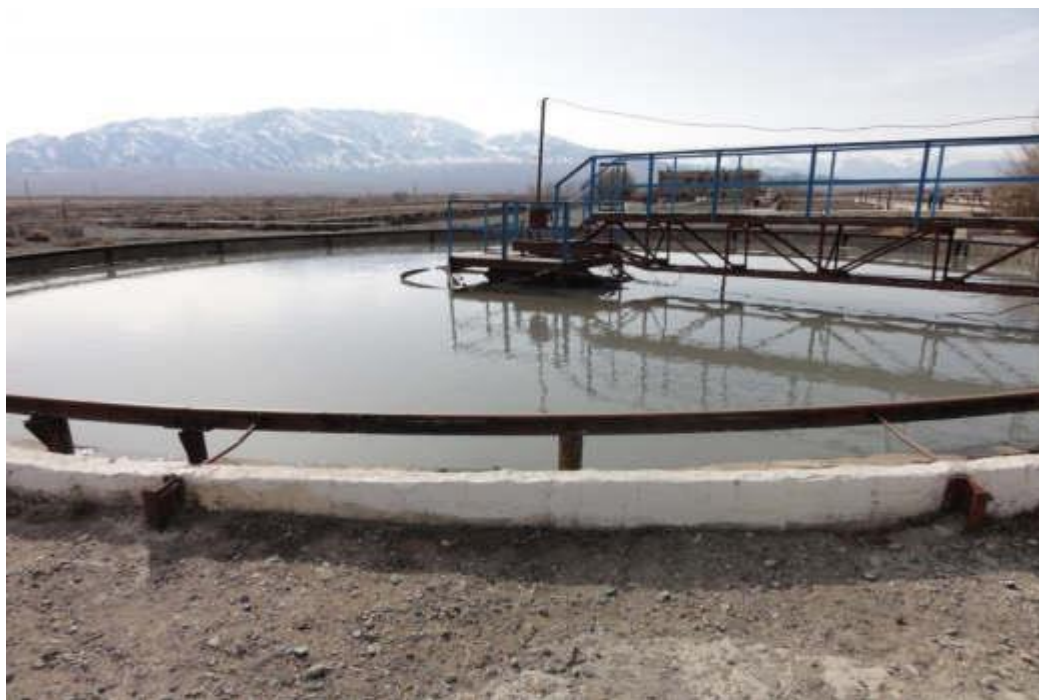
Фото 3. КОС Балыкчы. Отстойник
