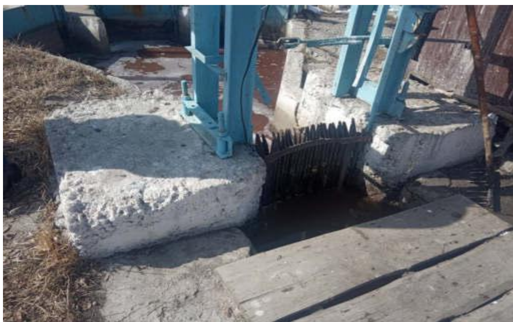
Фото 8. КОС Каракол. Распределительная камера первичного отстойника
