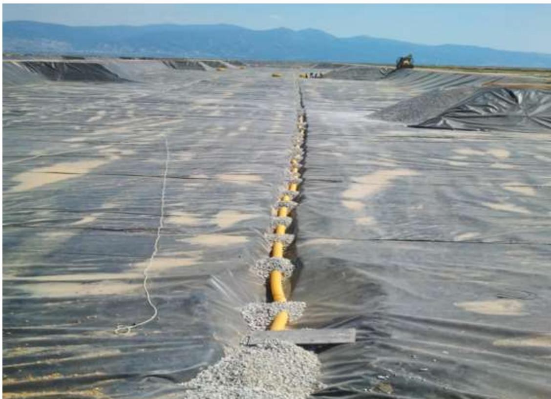
**Рисунок 7-8.** Вид дренажных каналов
