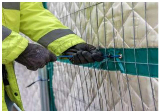
**Рисунок 35. Портативный временный акустический экран, брезентовый шумозащитный барьер**
