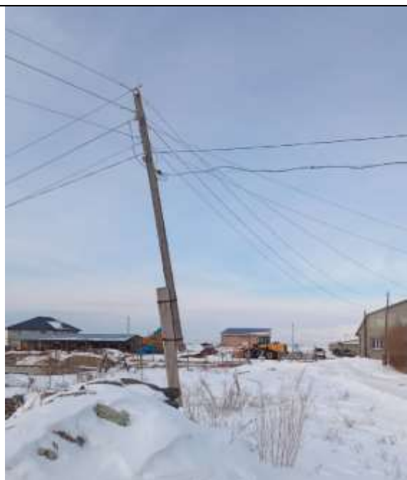
Существующая линия электропередач и деревянные опоры.
