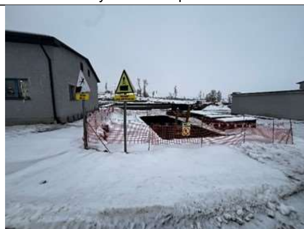
На участках разработки грунта необходимо было предусмотреть ограждения
