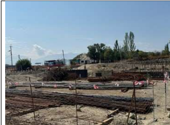
Строительные материалы хранятся отведенной и отмеченной территории.
