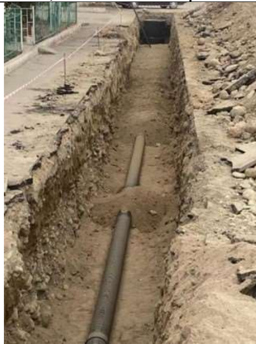
Обеспечено ограждение (установлена сигнальная лента, что свидетельствует о наличии контроля по периметру и обозначения опасной зоны) — ул. Тюпская
