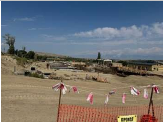
Установлено ограждение и информационный щит о мерах безопасности
