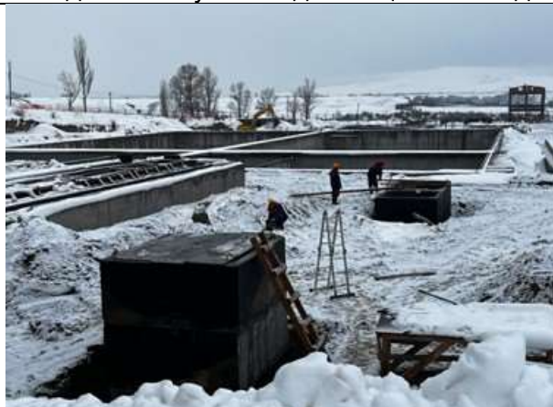
Рабочие, использующие защитные каски и зимнюю спецодежду, а также наличие экскаватора и лестниц (механизированная поддержка и обеспечение доступа для вертикального перемещения)
