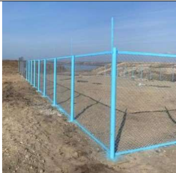
Площадка канализационного приемного резервуара с засыпкой и ограждением
