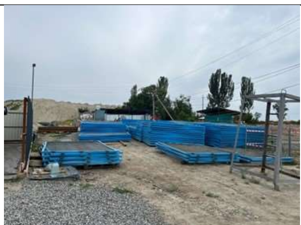
Материалы для опалубки хранятся в специально отведенных местах
