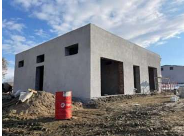
Трансформаторная - Соблюдаются надлежащие требования к устройству строительных материалов
