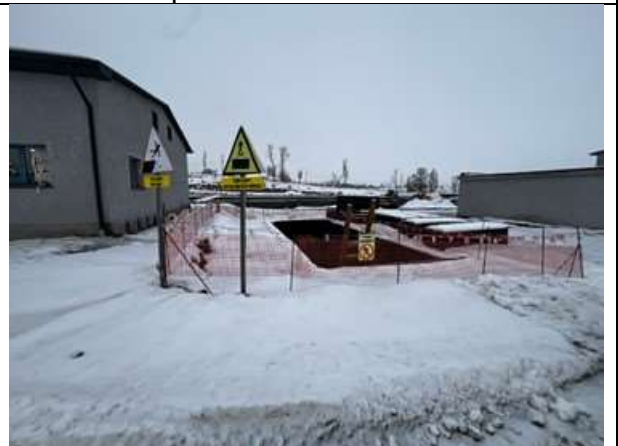
Установлены многоязычные предупреждающие знаки об опасности и сигнальное ограждение из красной сетки
