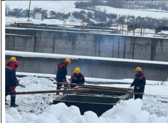
Рабочие обеспечены зимней защитной одеждой для строительства
