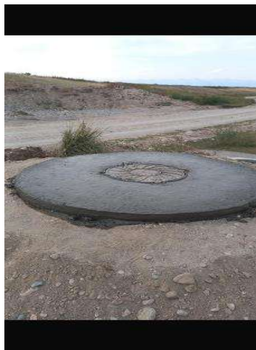
КРЫШКИ КОЛОДЦЕВ ПОСЛЕ РЕАБИЛИТАЦИИ
